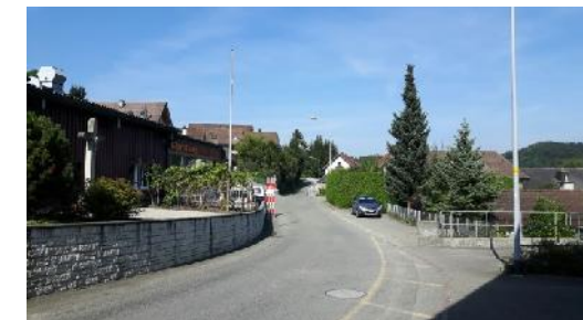
Erneuerung Dorfstrasse Büblikon 3. Etappe
