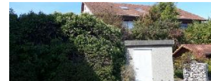
Erneuerung Trafo-Station Schulhaus
