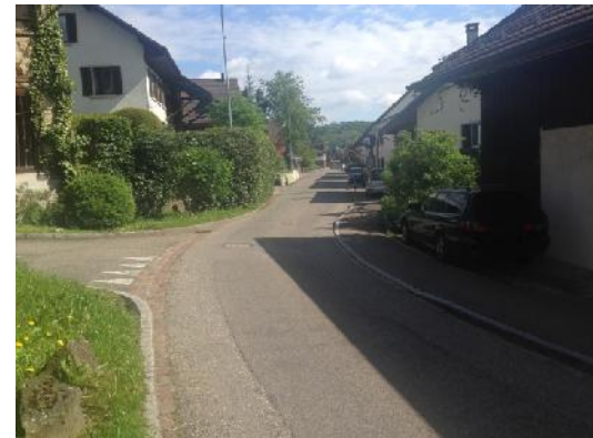
Erneuerung Dorfstrasse Büblikon 2. Etappe
