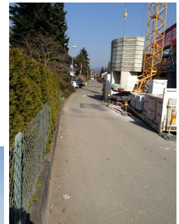
Erneuerung Laubisbach- strasse mit Werkleitungen
