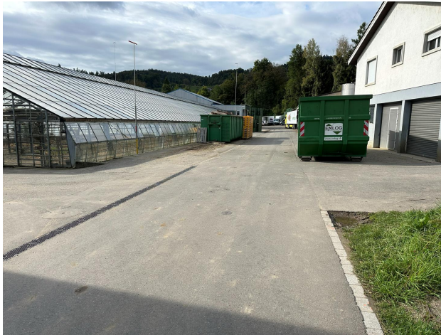
Projektstart / Anschlusspunkt Moosweg Nord
