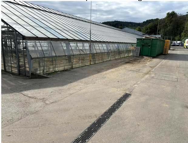
Parzelle 773 / Standort Neubau Lagerhalle
